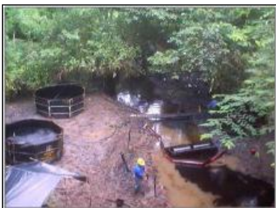
Figura 3. Detalle de la técnica de remediación
