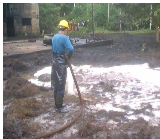
Figura 1. Lavado del suelo contaminado
